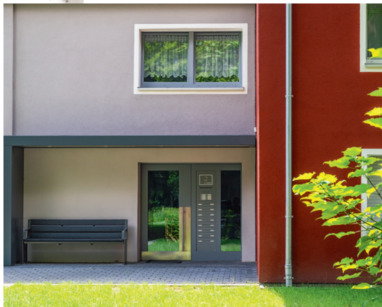
Im Rahmen der Modernisierung haben die Fassaden einen neuen Anstrich bekommen
