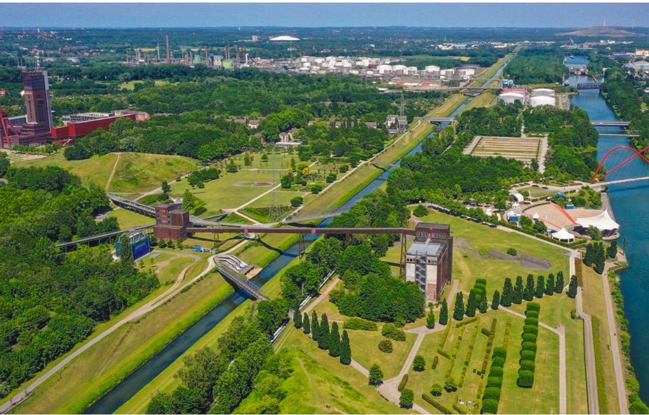
Auf der Emscherinsel im Gelsenkirchener Zukunftsgarten befindet sich der alte Kohlenbunker, in dem VIVAWEST eine Erlebniswelt „Wohnen“ gestaltet
