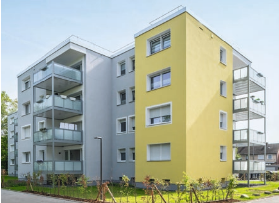
Frische Fassaden und ein neues Erscheinungsbild: So präsentieren sich die modernisierten Bestände in Moers-Meerfeld (links), Oer-Erkenschwick (ganz oben) und Hamm
