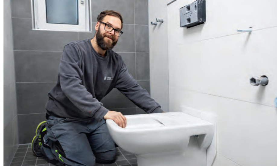
Bei Modernisierungsprojekten gehört der Einbau von Toiletten und Waschbecken zu den letzten Handgriffen von Pascal Schemberg
