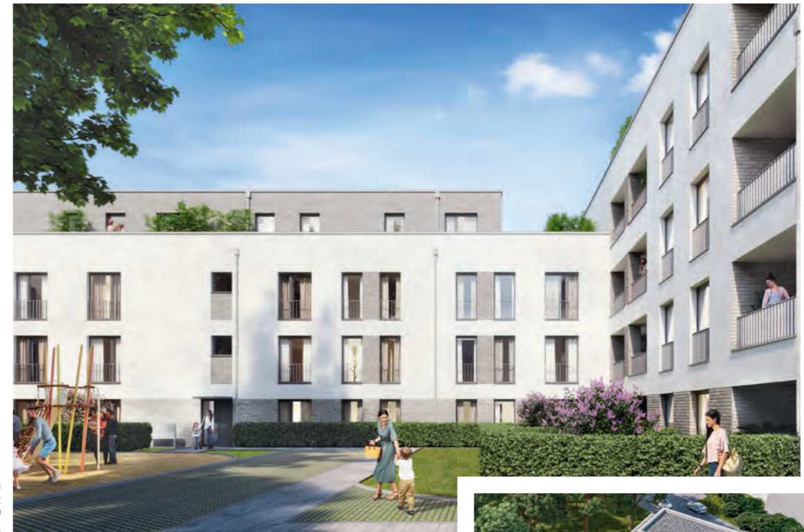
Beim Bau der neuen Wohnungen legt VIVAWEST Wert auf moderne Standards
