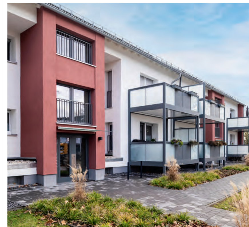
Die sanierten Häuser strahlen in modernen Farbtönen. Ein Highlight sind die deutlich größeren Balkone
