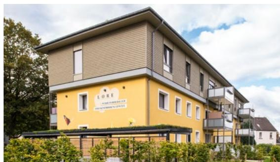
Im Zuge der Modernisierung hat VIVAWEST die Fassaden saniert, Balkone angebracht und Dachaufstockungen errichtet
