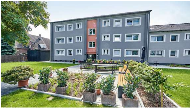
Bei vielen VIVAWEST-Mietshäusern wurde die energetische Bilanz deutlich verbessert
