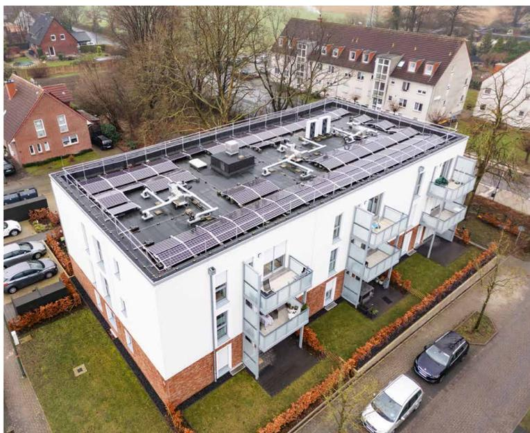
Im Rahmen eines Pilotprojekts von VIVAWEST erzeugt eine Photovoltaikanlage auf dem Dach Strom für den Betrieb von Luft-Wasser-Wärmepumpen
