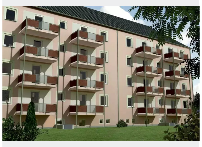
Hofansicht mit Balkonanlagen
