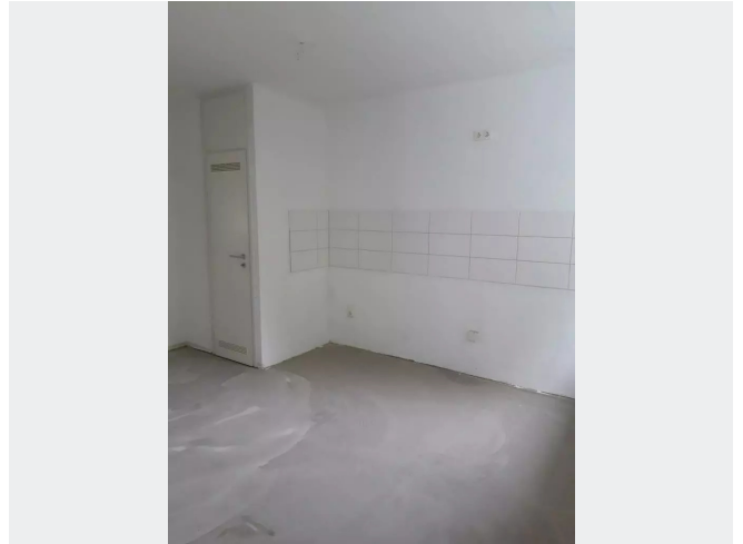
Küche mit Balkonzugang
