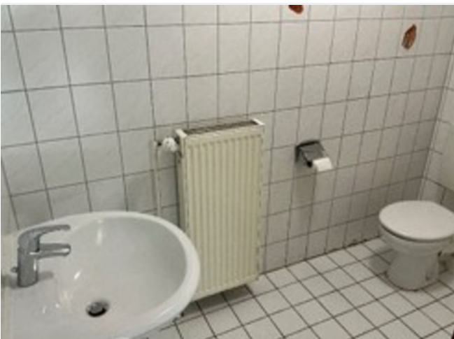
Duschbad ohne Fenster
