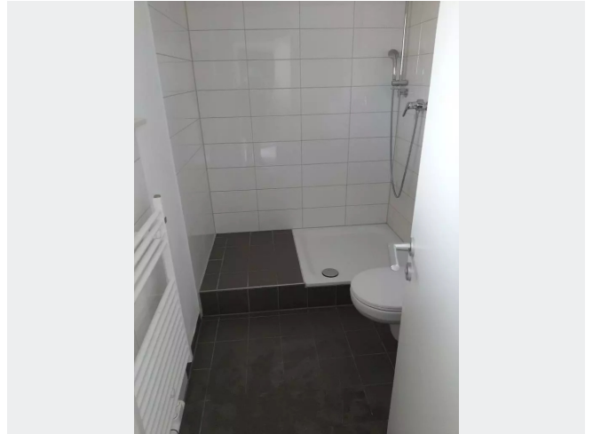
Duschbad mit Fenster
