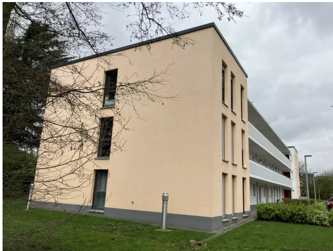
Außenanlage Objekt Beispiel
