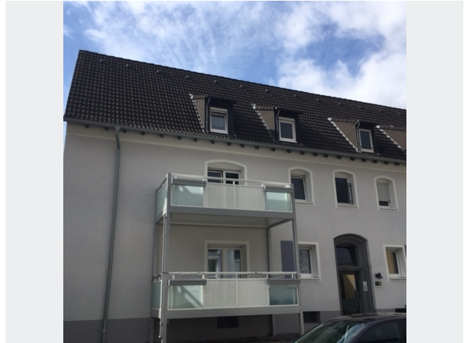
Hünenweg 5 IOGL Fassade vorne
