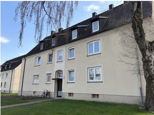
Am Urnenfeld 5 Strassenseite
