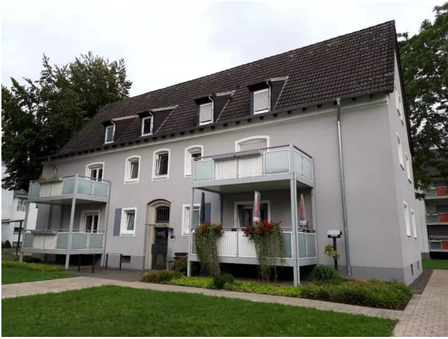
Im Drubbel 2 Strassenansicht
