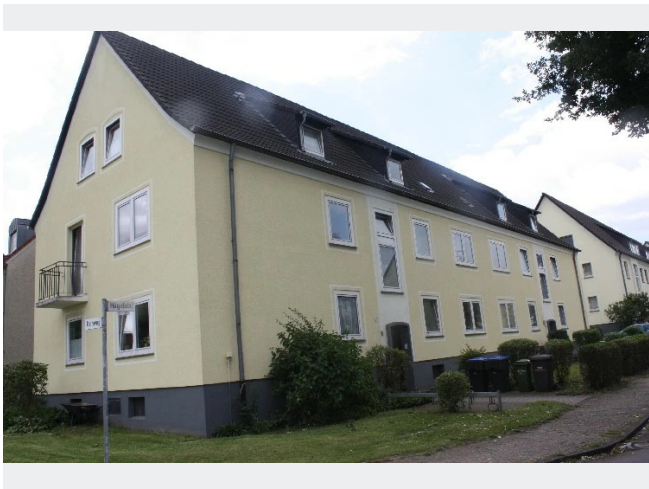
Hügelstr. 2 vor Modernisierung
