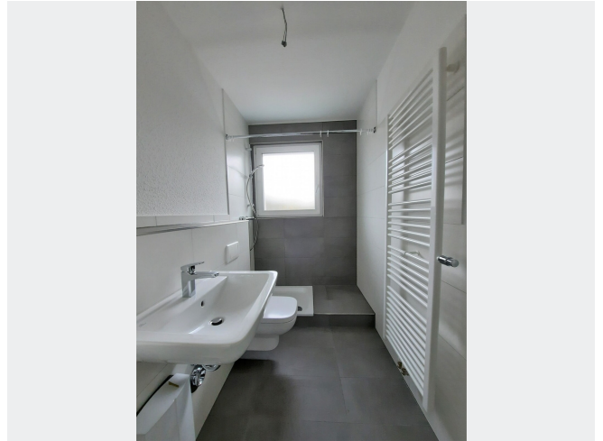
Bad nach Modernisierung
