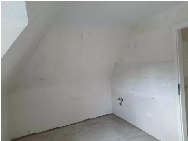
Küche Bsp. nach Modernisierung
