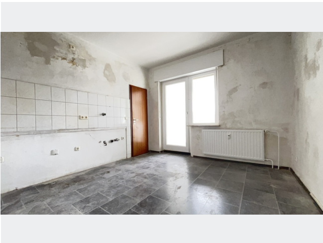
Küche mit Zugang Balkon
