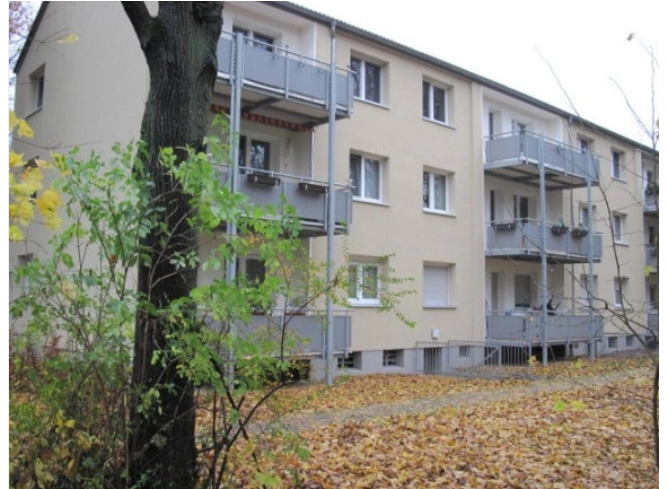
neue Fassade / Balkone
