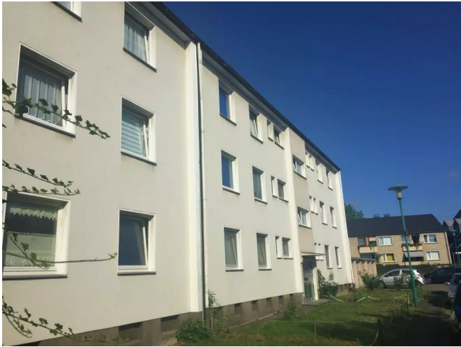
Hausansicht vor Modernisierung
