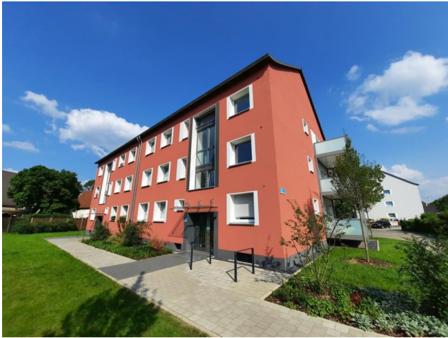
Fassade Am Giesenhof 18 bzw 20
