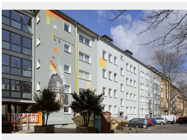
Fassade Unnaer Str.
