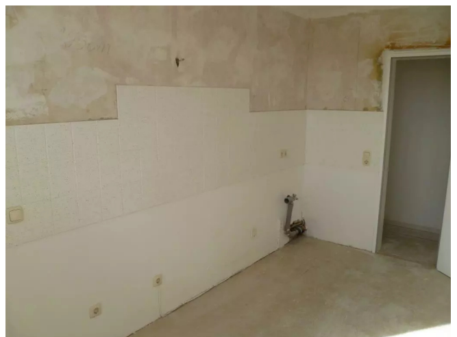
Küche mit Abstellraum
