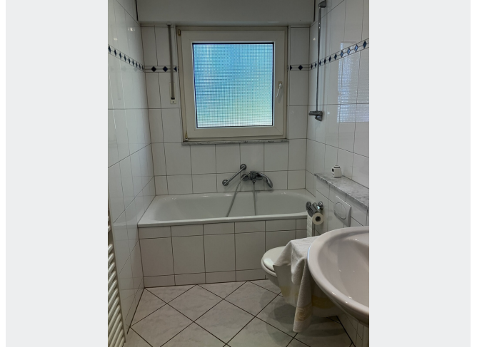
Wannenbad mit Fenster
