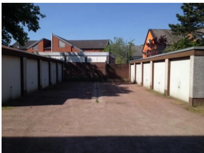
Garagenhof hinter dem Haus
