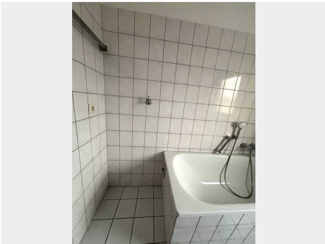
Waschmaschinenanschluss
