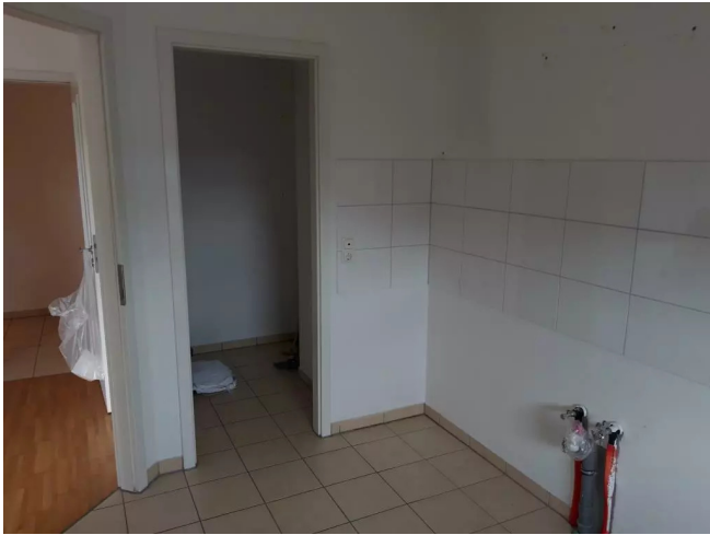
02.1 Küche Blick Abstellkammer
