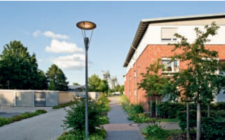
Häuser in Marl werden aus der Tiefe eines Bergbauschachtes mit Wärme versorgt
