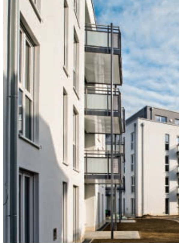
In der Klimaschutzsiedlung in Köln wird innovative
