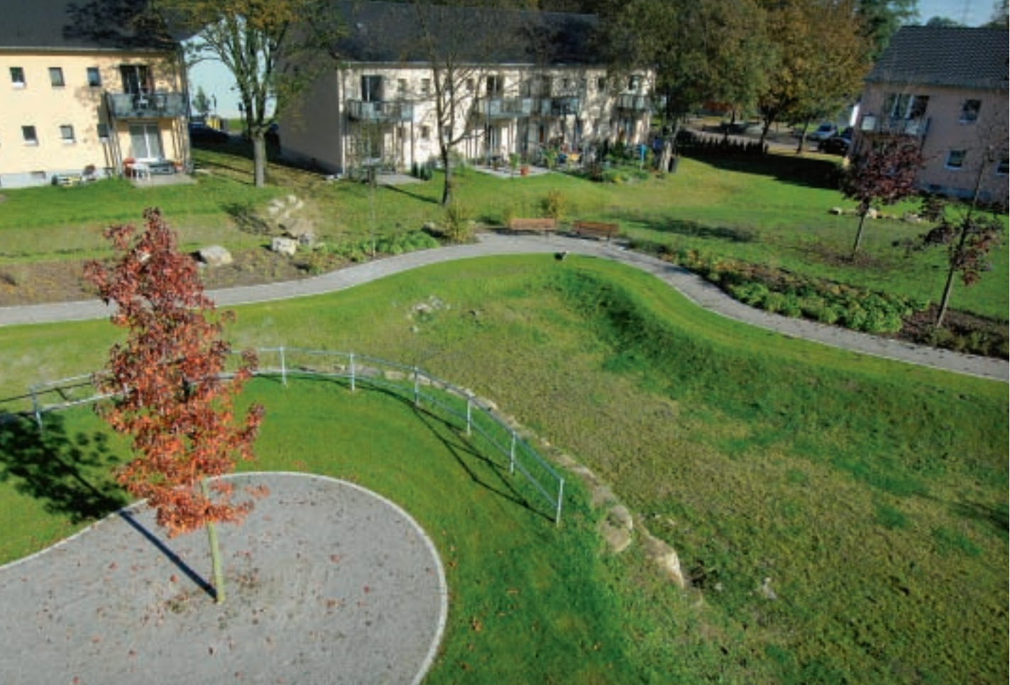
Regenwasserretentionsbecken in der Siedlung Welheimer Mark, Bottrop. Das Projekt ist Teil des Masterplans Emscher Zukunft
