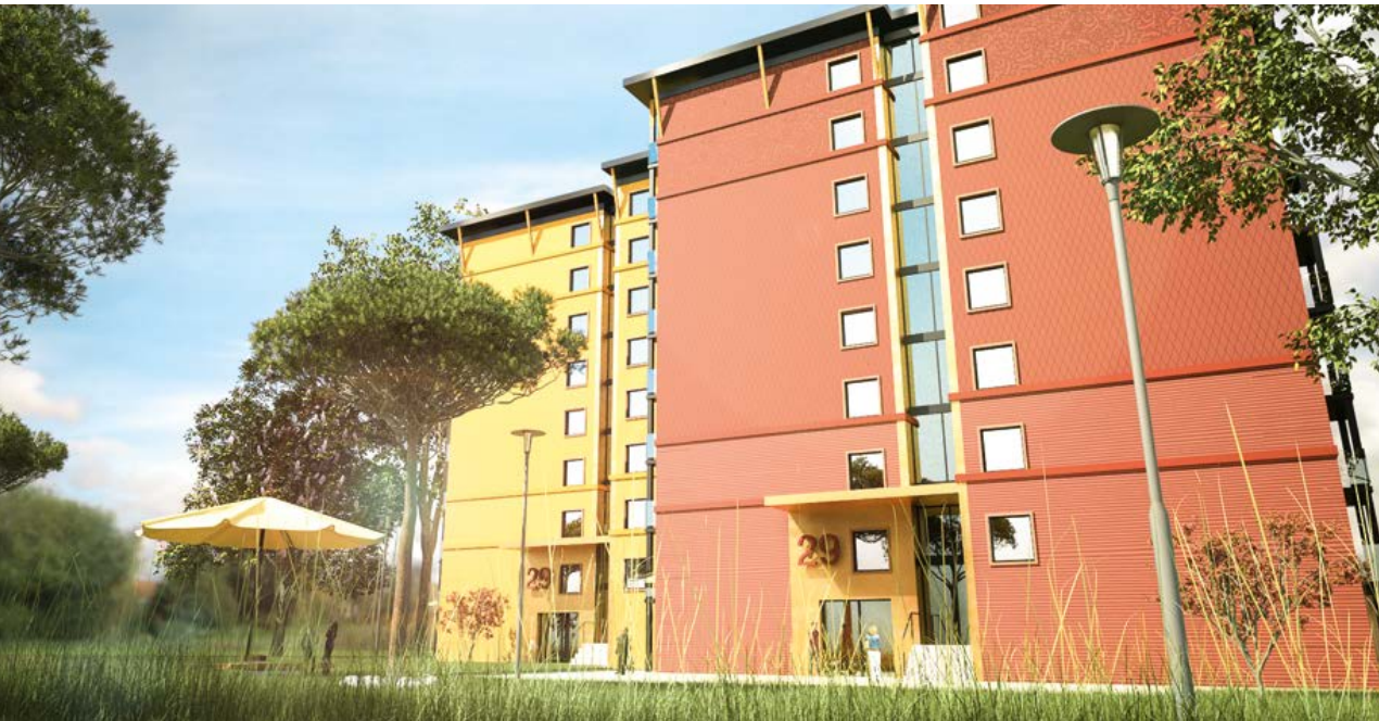
Die Siedlung Eicker Wiesen in Moers wird im Zuge des Pilotprojektes „Generationengerechtes Wohnen im Quartier“ modernisiert
