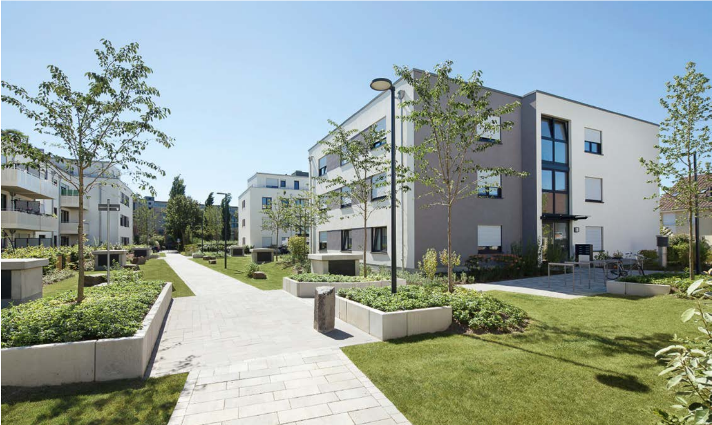
Das Quartier „VIVA WEIDEN“ in Köln. Den Bau von Wegen, Hauseingängen und Treppenanlagen sowie die Bepflanzung der Grünflächen übernahm HVG Grünflächenmanagement
